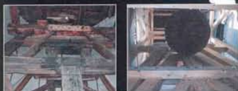
Der Glockenstuhl: links vor der dringend notwendigen Sanierung und rechts, wie er sich heute präsentiert. Im großen Bild darüber: der erneuerte Turm.
