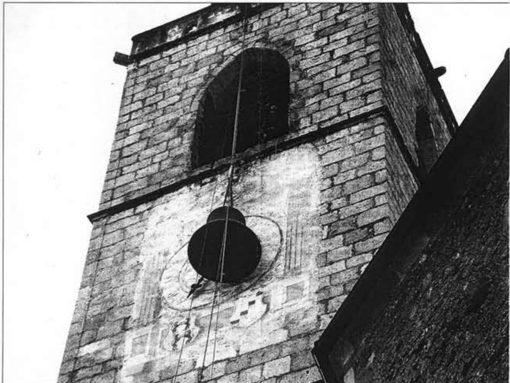
Behutsam wird die „Annemarie“, die größte Glocke aus dem Jahr 1526, aus dem Glockenturm abgeseilt. Die 3226 Kilogramm schwere Glocke wird als erste aus dem Turm entfernt.
