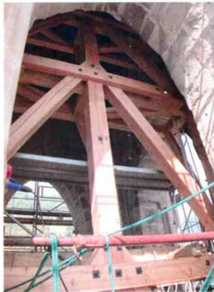
Der Einbau des neuen Glockenstuhls war der wichtigste Teil der Restaurierung.
